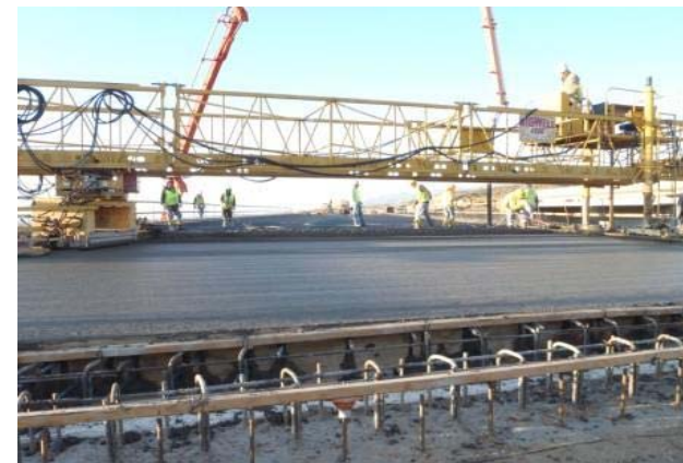
US 93 Deluge Wash Bridge Deck Pour
